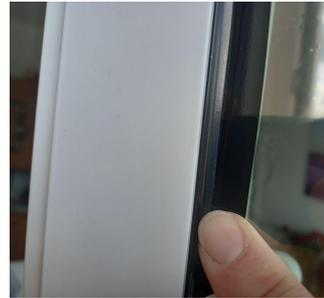
Beginnen Sie am Rand des Fensters. Entfernen Sie die Folie mit einer Hand und kleben Sie das Edge Sealing Tape mit der anderen Hand überlappend auf die applizierte Folie und das Glas, um ein gutes Abdichtungsergebnis zu erzielen.
