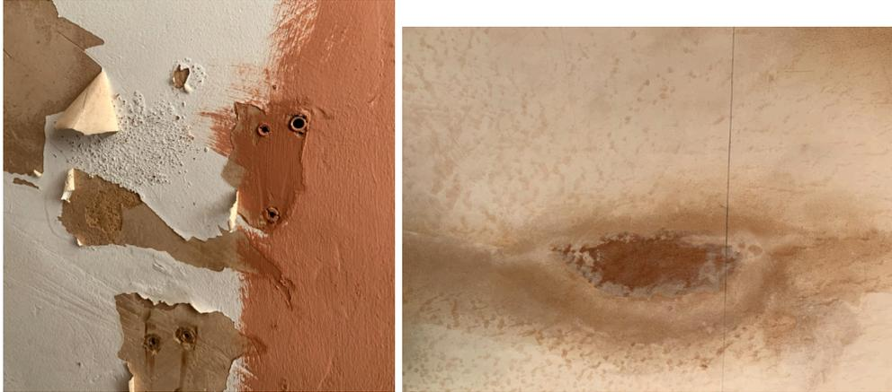
Abbildung 1. Beispiele für Wände, die vor der Verklebung repariert werden müssen
